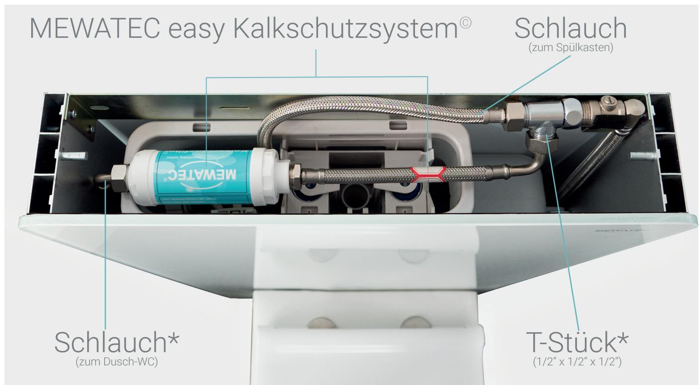
\*In MEWATEC Komplettanlage bereits enthalten
